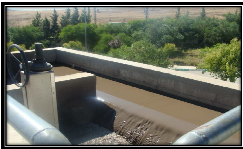
Figure II.11: La recirculation des Boues.
