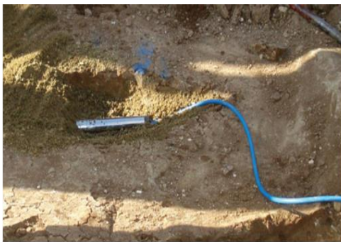
Piézomètre électrique à corde vibrante.
