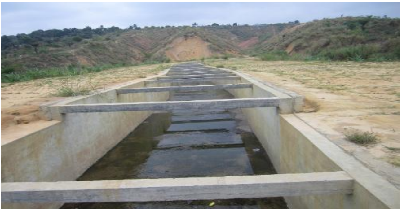
Figure1 : Canal d'évacuation des eaux pluviale système séparatif
