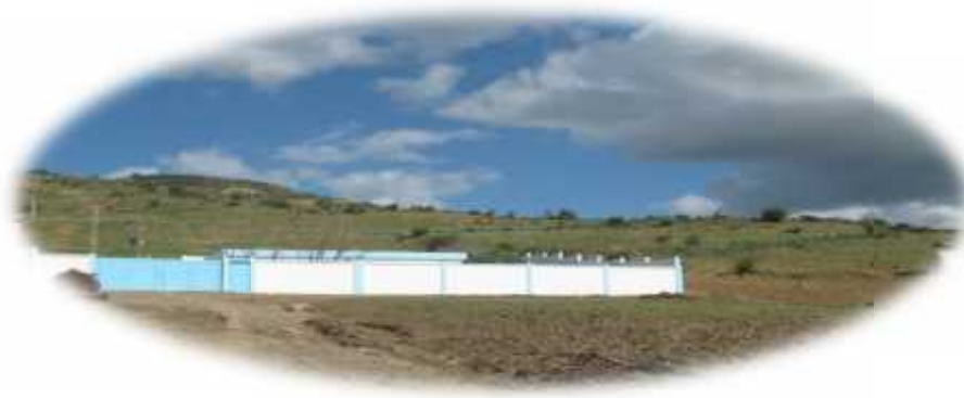
Figure N°II-2 : Station de reprise N°02 vue extérieure[2]
