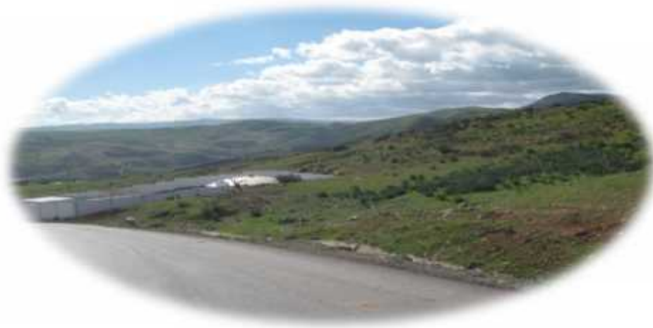
Figure N°II-1 : Station de reprise N°01 vue extérieure[2]
