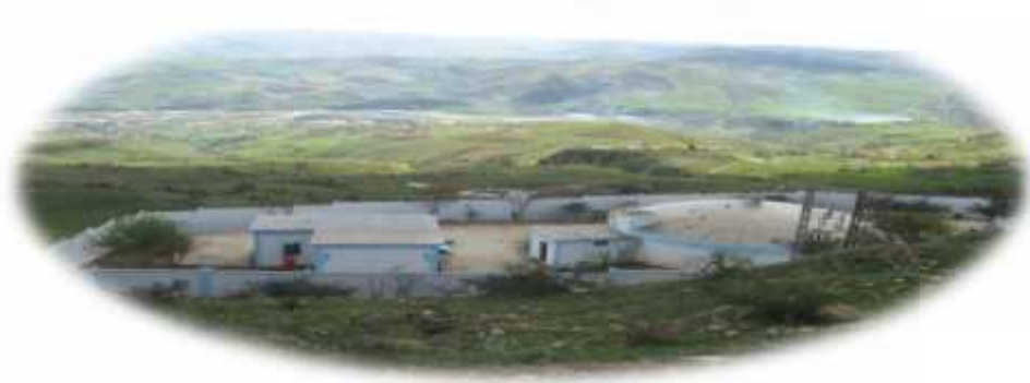
Figure N°II-3 :Station de reprise N°03 vue extérieure[2]
