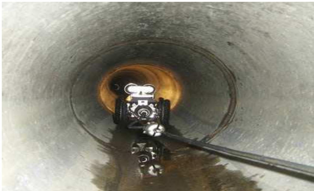
Figure 8 : Photo d'une inspection télévisée, Source : [8]
